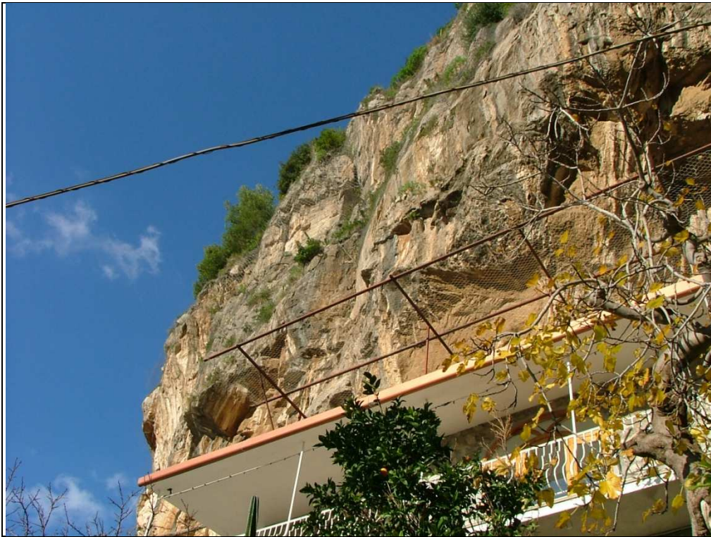
Foto 11. Fratturazione nelle aree sommitali del costone roccioso della zona B e rete metallica in aderenza.
