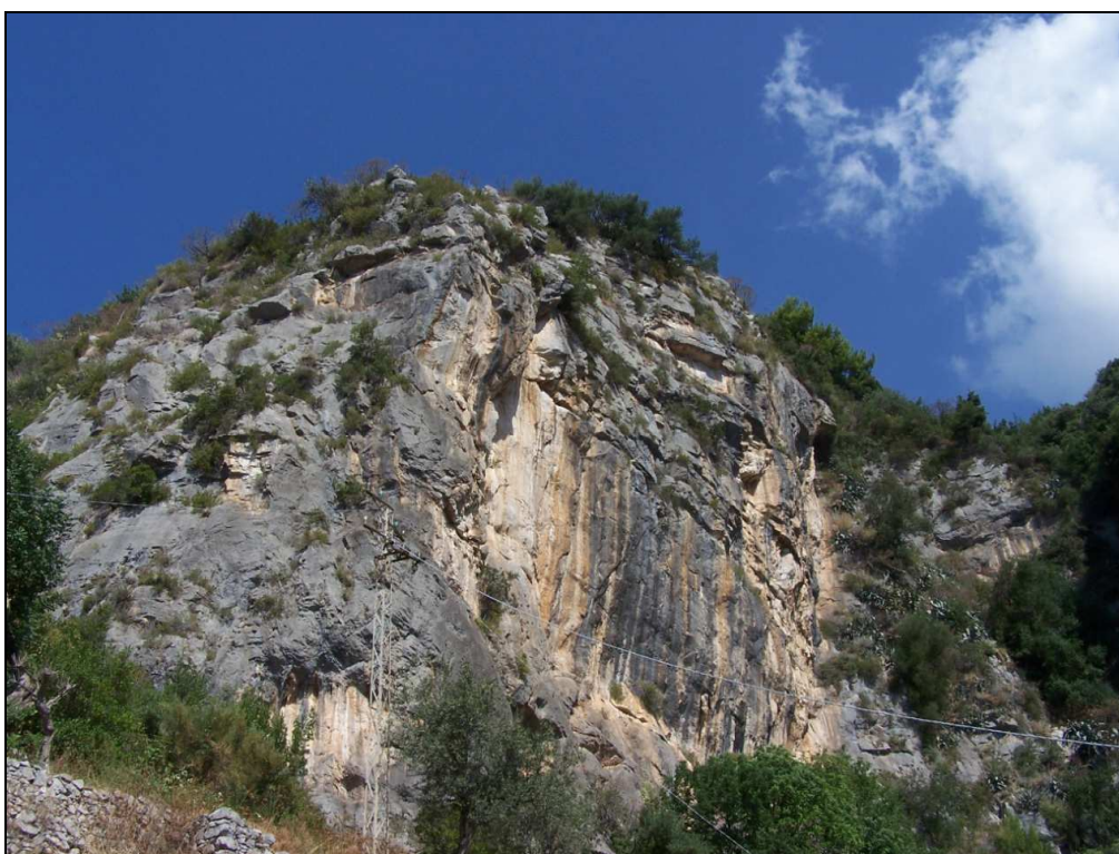
Foto 1. La parte di costone più significativa oggetto di consolidamento a monte dell'area cimiteriale.
